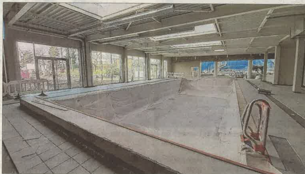
Le vieux bassin du centre nautique datait de 1976. Il a été démolli et remplacé par un nouveau, qui sera équipé d'un fond mobile. Photo Progrès/Thomas BRUGNOT
